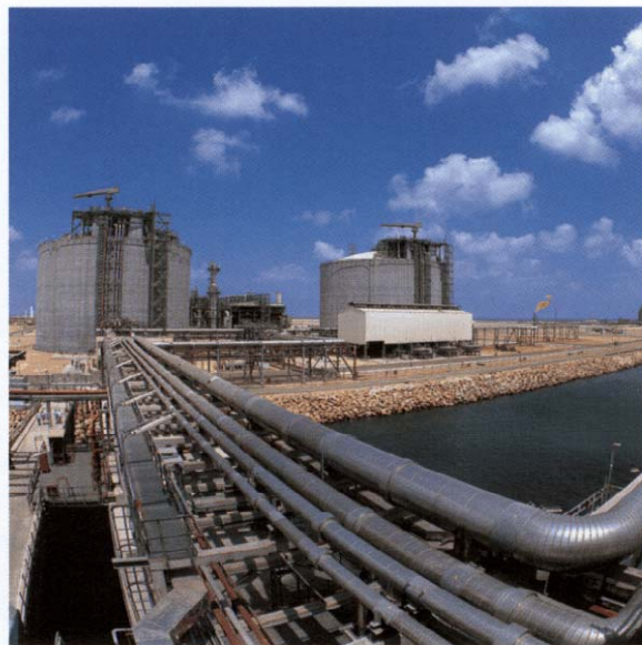
Egitto – Impianto di liquefazione gas di Damietta.
