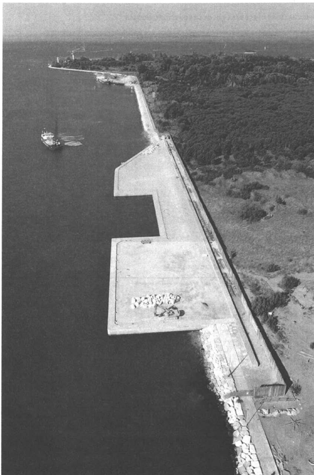
Bocca di Malamocco: veduta d'insieme delle lavorazioni per la realizzazione della spalla nord (lato Alberoni)
