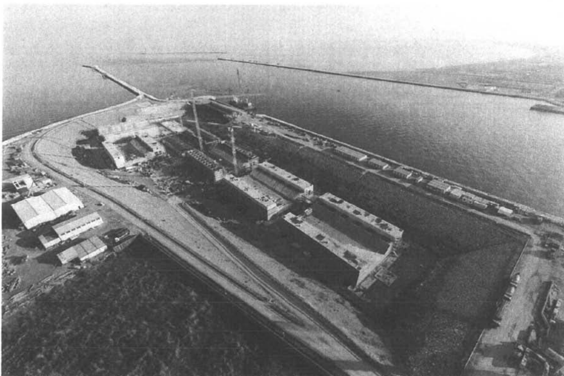
Bocca di Chioggia: la costruzione dei cassoni di soglia della barriera di Chioggia in avanzata fase di realizzazione
