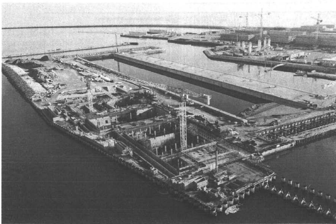
Bocca di Malamocco: particolare della vasca ove verranno ubicati gli impianti e gli edifici tecnologici
