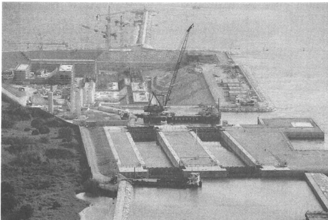
Bocca di Chioggia: In primo piano le conche di navigazione per pescherecci. In alto il bacino lato mare messo all'asciutto e utilizzato come tura per la costruzione dei cassoni di soglia e di spalla
