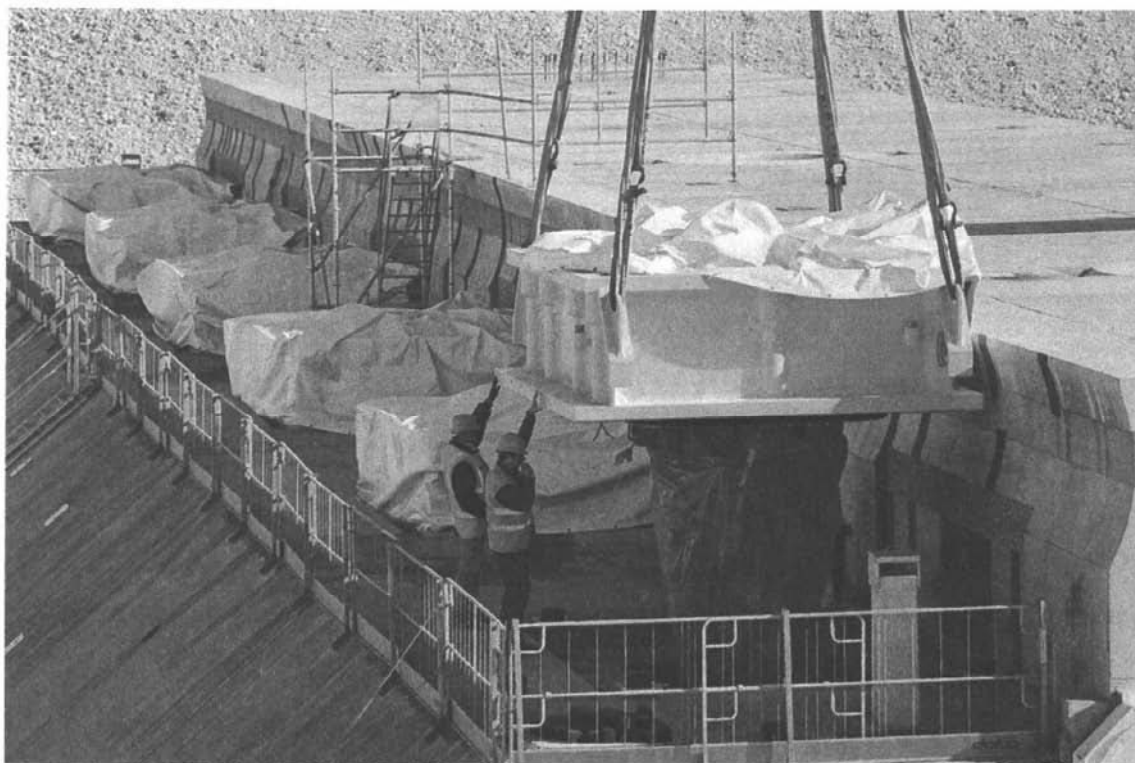
Bocca di Lido - Treporti: lavorazioni per l'installazione in un cassone di soglia di un connettore e del rispettivo elemento femmina, in cui verrà incernierata la paratoia
