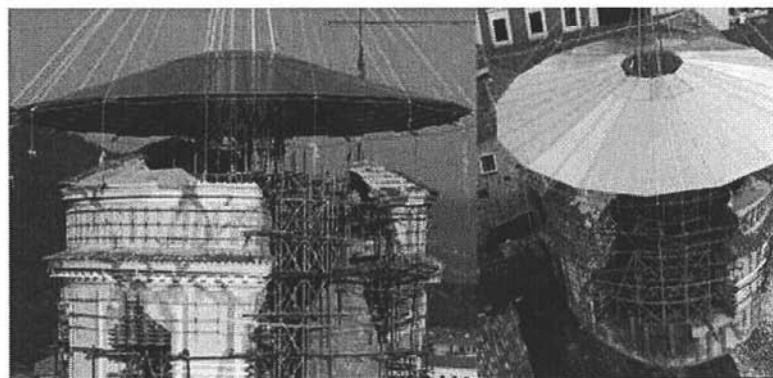
Chiesa di S. Maria del Suffragio a L'Aquila – fasi della messa in sicurezza della cupola
